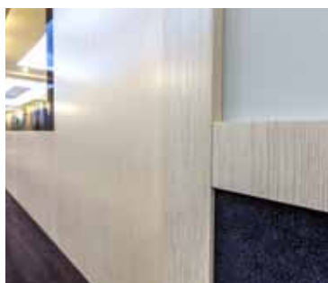
zabudowa z paneli ściennych
